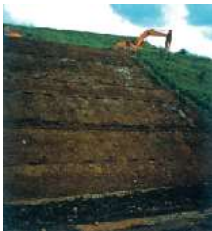
カルドレーンを埋設した法面
