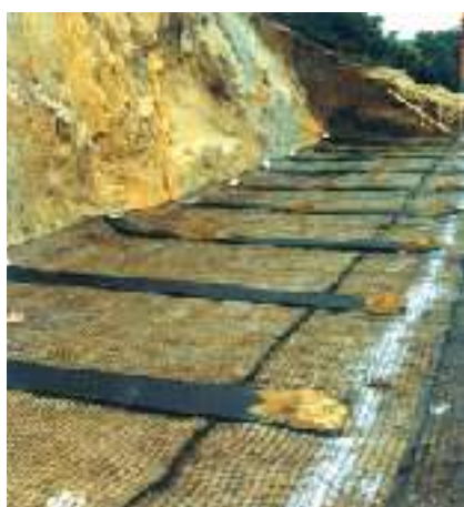
カルドレーン（排水材）とテンスー（盛土補強材）併用による施工状況
