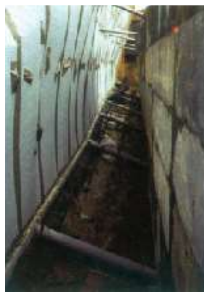
排水パイプ等のジョイント部はコンクリートミルクが浸入しないように布粘着テープ等でシールします
