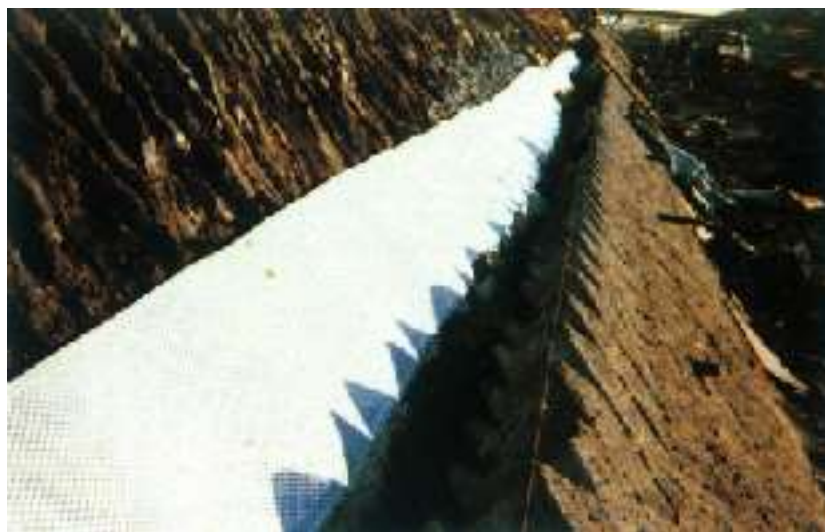
カルドレーンを裏型枠兼用としたブロック積擁壁
