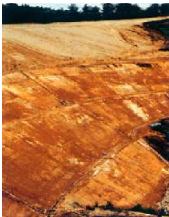
カルドレーンを使用した高盛土の全景
