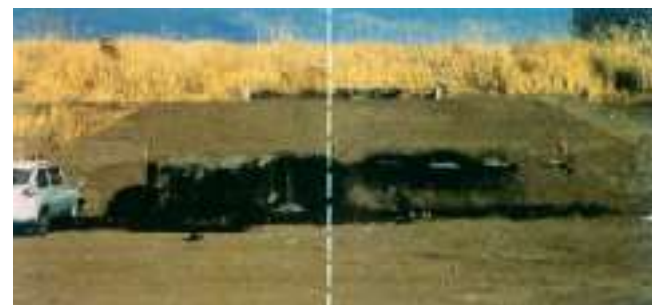
撒水中止2日後の写真です。 明らかにカルドレーンフィルター側（右半分）は乾いていることが確認されました。
