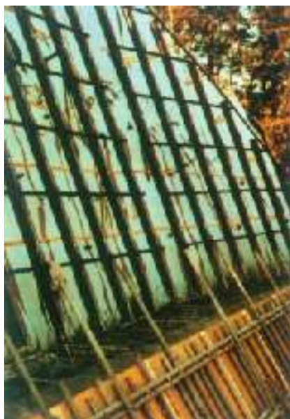
カルドレーンによる復旧工事
