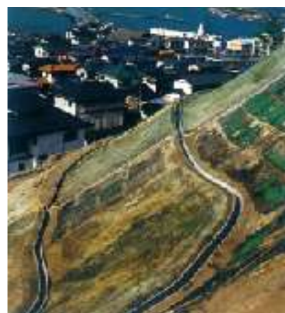
完成後の急斜面
