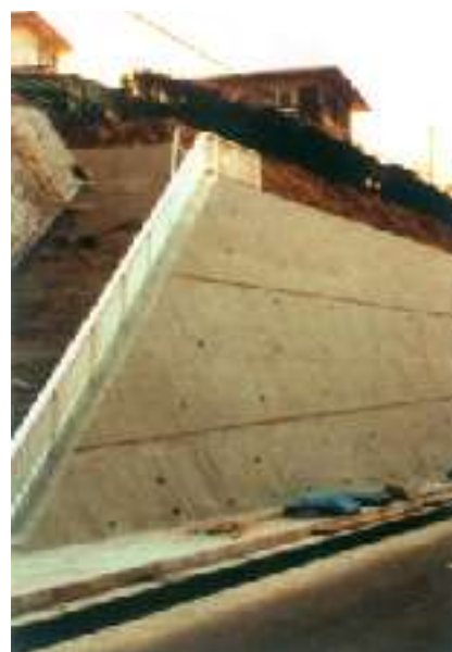
完成後の擁壁
