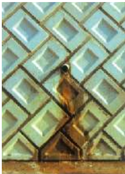
水抜穴からの排水状況
