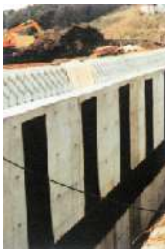
河川拡幅工事擁壁
