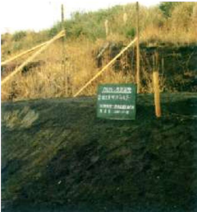
サンドフィルターを30cm厚さで敷設したところ。 良質の砂が多量に必要であると同時に施工の確実性に不安が残ります。
