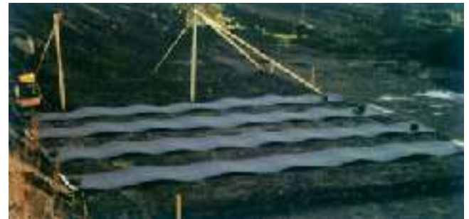
カルドレーンを120cmピッチで敷設したところ。
