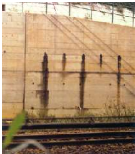
水抜き穴からの排水状況
