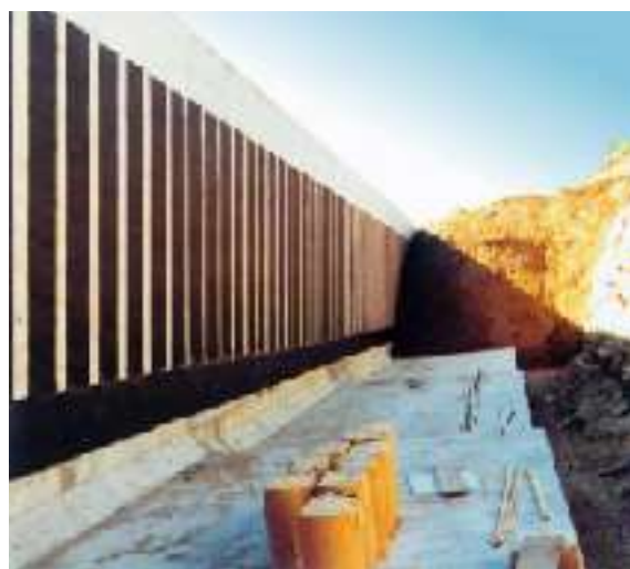
カルドレーンをコンクリート擁壁に施工したところ
