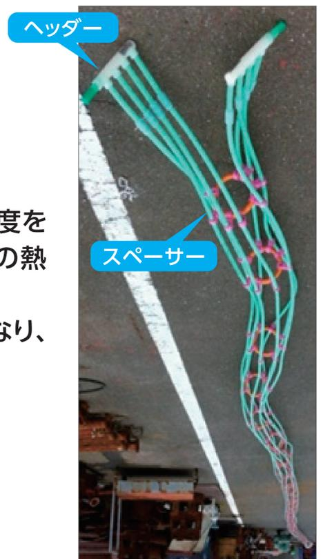
【施工事例】 ※大阪府茨木市に設置 ジオメックス R3<sup>®</sup>で深度30m掘さくした状況
