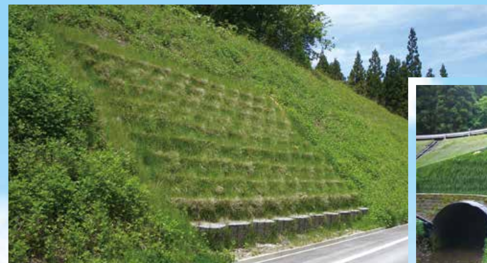
切土・盛土は テンサー® で補強と緑化
