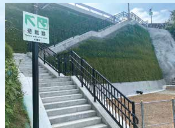
避難路の盛土にもテンサー®
