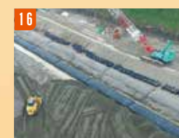
ジオチューブ 浜崖後退抑止工用 サンドバック
