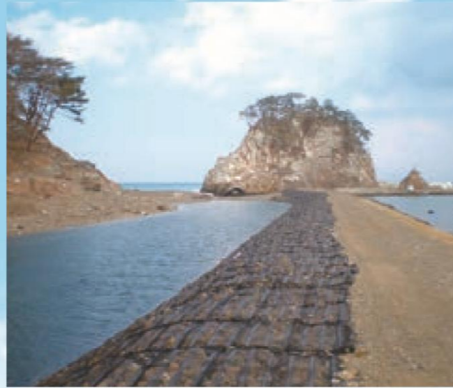
どこまでも続く護岸のジオシェルトン®
