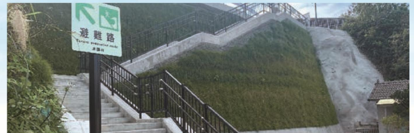
避難路の盛土にもテンサー®
