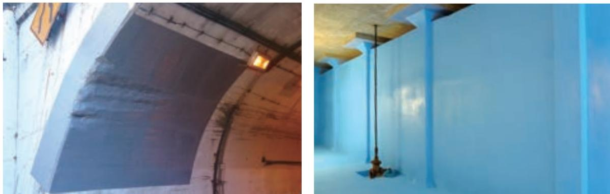
タフネスコート®をコンクリート構造物の表面に吹き付けることにより、部材の断面が破壊した後も形状および耐荷力を保持します。構造物の崩壊を抑制することで減災が期待できます。
