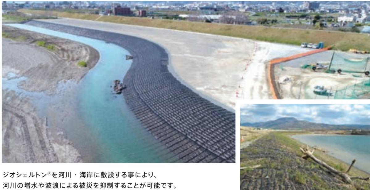
ジオシェルトン®を河川・海岸に敷設する事により、河川の増水や波浪による被災を抑制することが可能です。また、応急復旧用の備蓄材としても採用頂いております。
